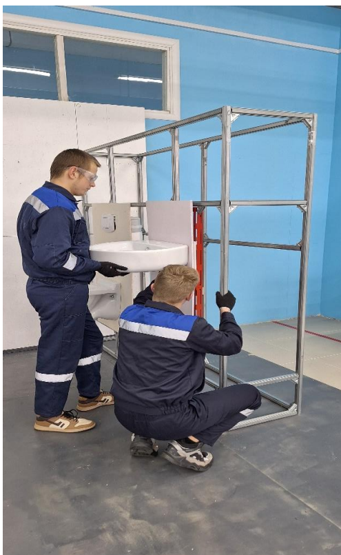
Рис. 3. Установка раковины
