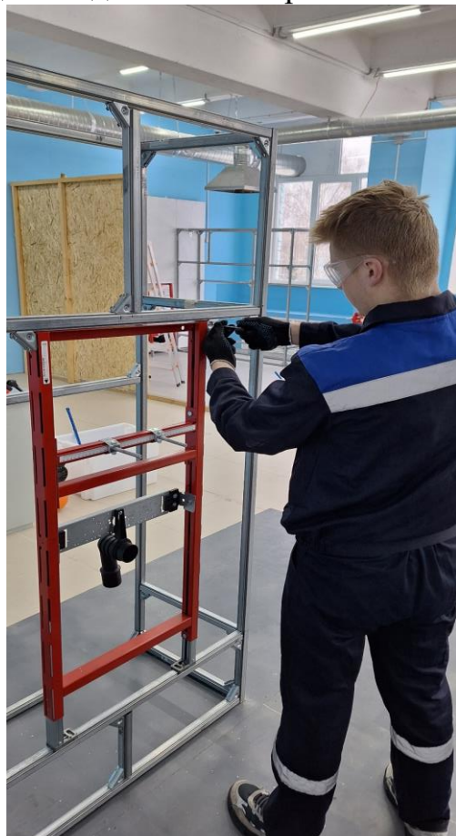
Рис. 2. Установка инсталляции для раковины
