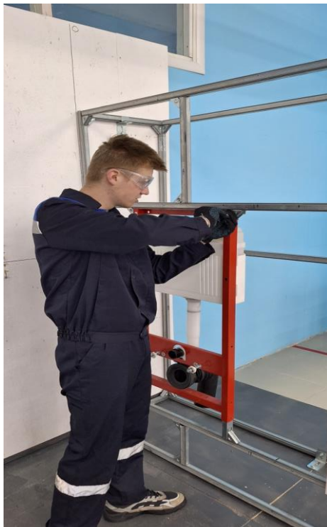
Рис. 1. Установка инсталляции для унитаза
