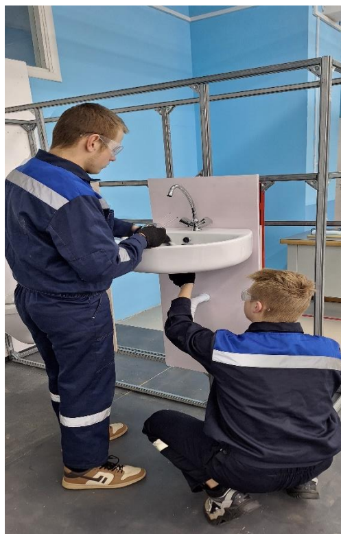
Рис. 4. Установка сифона
