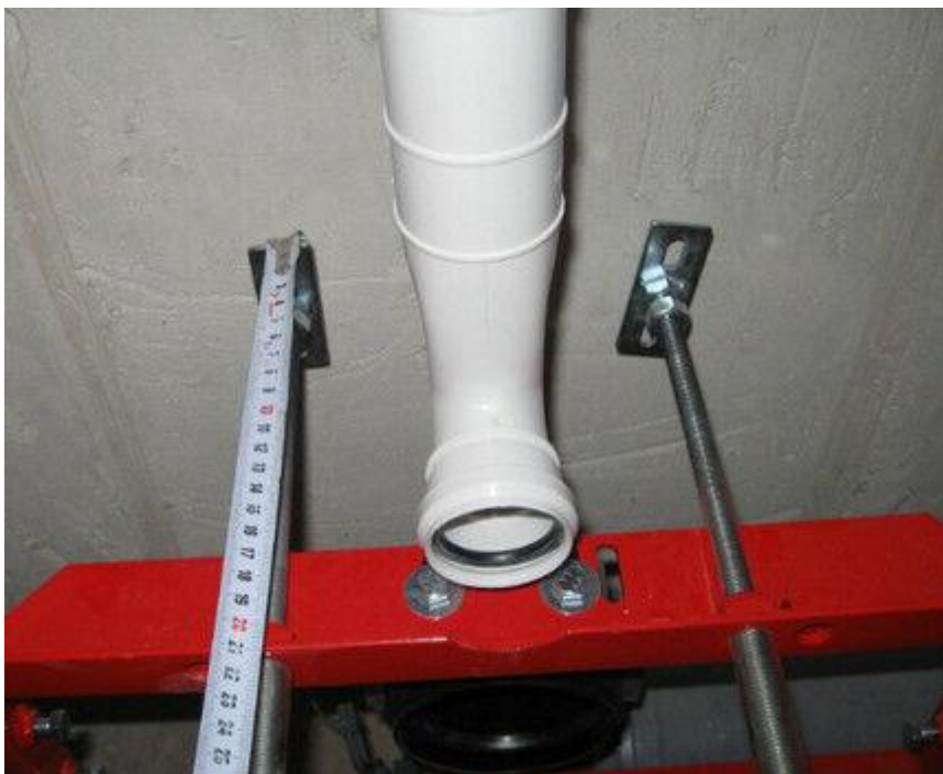
Рис.5 Очень важно при закреплении болтов проследить, чтобы расстояние от края каркаса до стены не превышало 21 см. Если этот параметр не соблюсти, то потом, когда будет установлена фальш-панель с декоративной отделкой, длины болтов не хватит для закрепления чаши унитаза.
