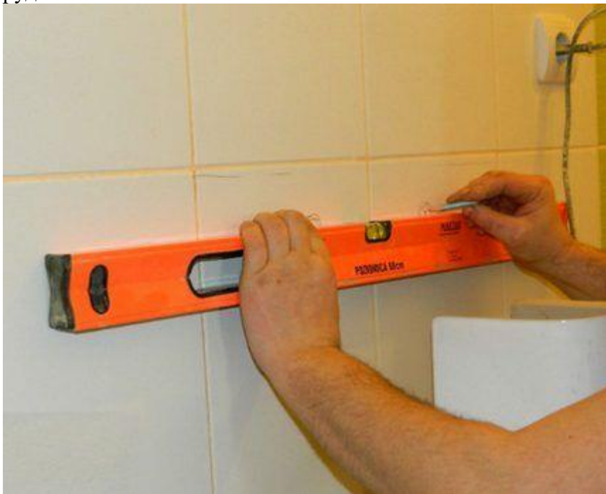
Рис.4 При осуществлении разметки нужно обязательно пользоваться уровнем. Он поможет выровнять систему по вертикали и горизонтали, что обеспечит ее последующую корректную работу
